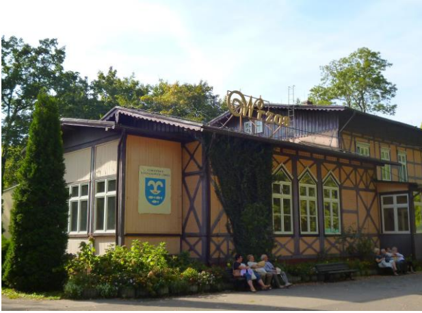
Ryc. 3. Pawilon Sanatoryjny „Wrzos” z 1874 r. w drewnianej konstrukcji muru pruskiego.
