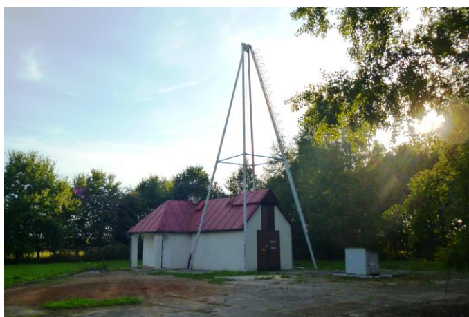
Ryc. 1. Budynek przepompowni solanki z otworu G-21.
